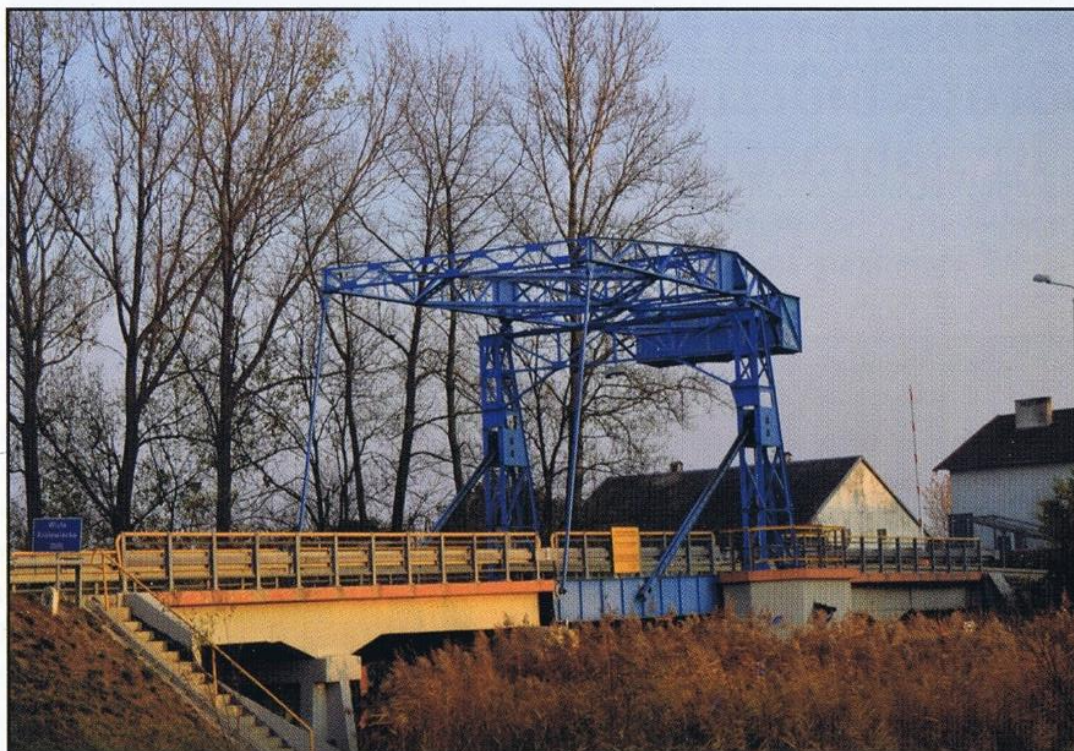
Zwodzony most drogowy w Rybinie na Wiśle Królewieckiej
